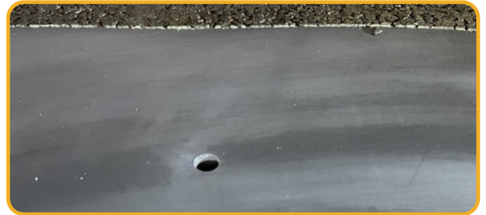
Afb. C.B | 1. Voer de kabels door de gaten in bodem
