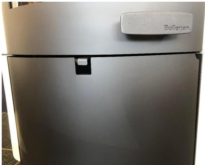
Das Bild zeigt die Tür in eingebautem Zustand. Der Schließpunkt der Tür kann bei Bedarf noch über die Magnetschraube eingestellt werden; die vertikale Neigung über den Türhalter.
