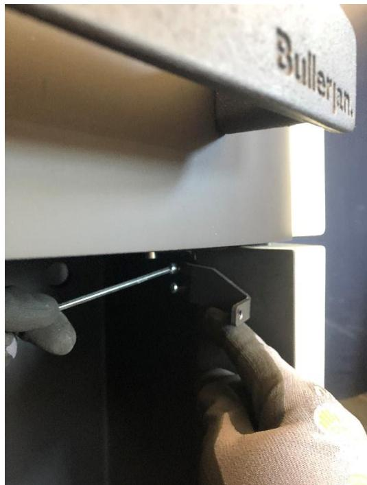
Richten Sie den Halter horizontal aus – ziehen Sie die Schrauben mit Hilfe eines Inbusschlüssels fest.
